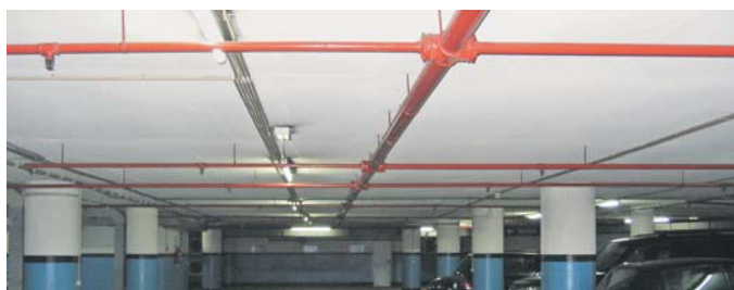
Fig. 1 Espaçamento máximo entre suportes de tubagens em aço ( e_{m\acute{a}x.} ).
